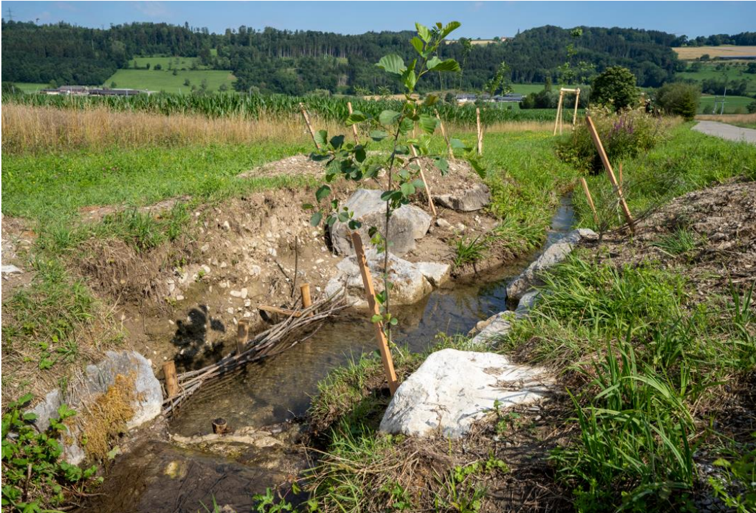
Foto 19 Oberer Abschnitt. Gesicherte Böschung rechts mit Blocksteinen aus der linken Böschung. Schwarzerle im Vordergrund rechts. Sie wird die langfristige Stabilisierung übernehmen, weil ihre Wurzeln ins Wasser wachsen werden. (6.7.2022)
