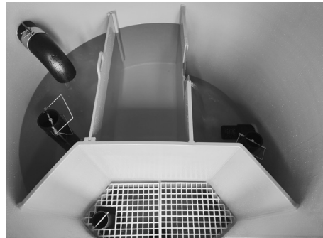
Innenbereich der Brunnenstube «Rainhau»* (Quellschüttung ca. 19 l/min)
