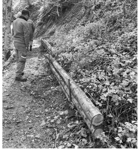
Neue Hangsicherungen entlang des Tobelwegs
