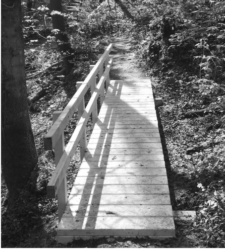
Ein neuer und sicherer Fussgängersteg
