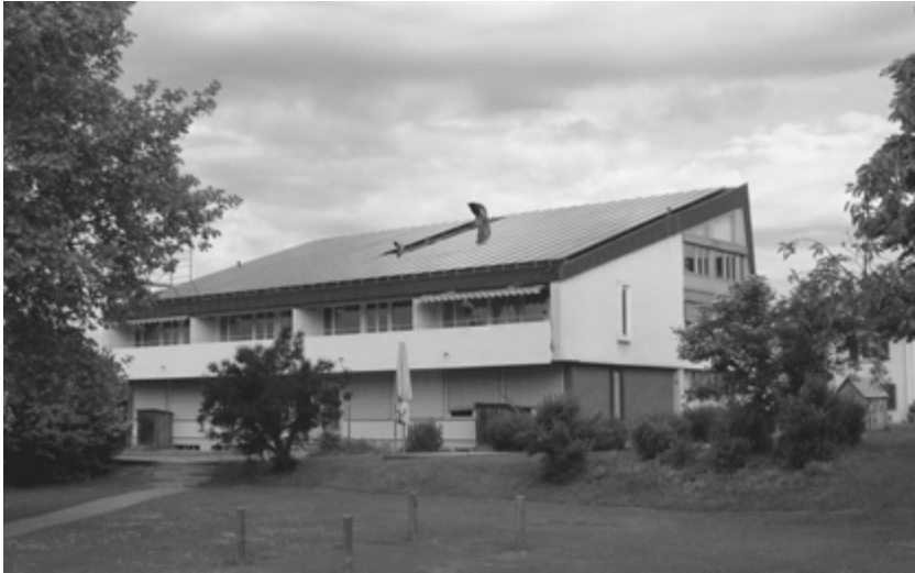
Fotovoltaikanlage auf dem Dach des Hauses Schachenstr. 7
