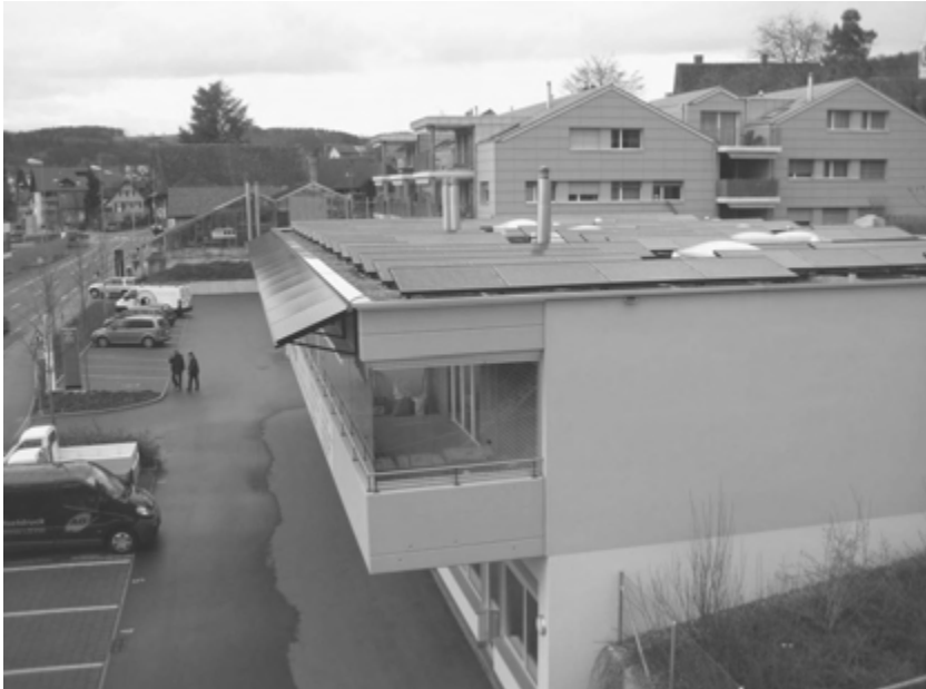
Grosse Fotovoltaikanlage an der Affolternstrasse 11 (Albis-Offset, M. Böni)
