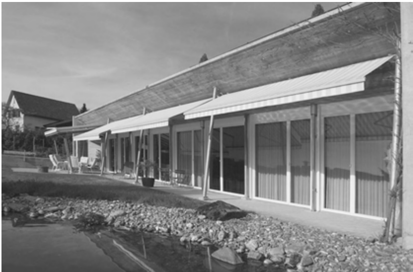
Niedrigenergie-Einfamilienhaus Haldenrebenstrasse 15, Hedingen (Baujahr 1997)
