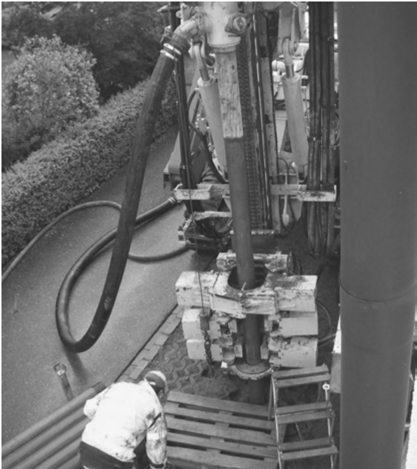
Erdsondenbohrung neben Haus Sunnemattstr. 11
