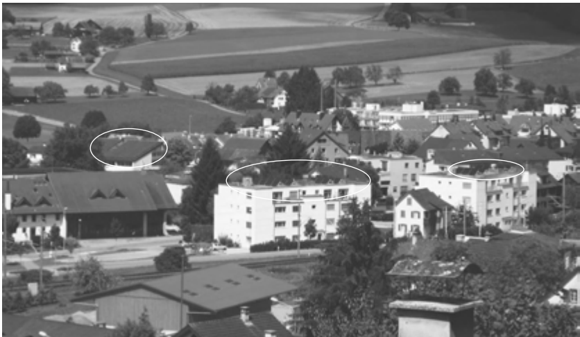
Solaranlagen an Schachenstr. 7 und Zwillikerstr. 17/19
