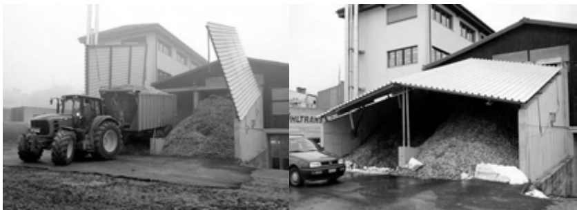
Schnitzelanlieferung in die befahrbaren Schnitzelsilos auf der Westseite der Schreinerei Girardi an der Maibenbrunnenstrasse .
