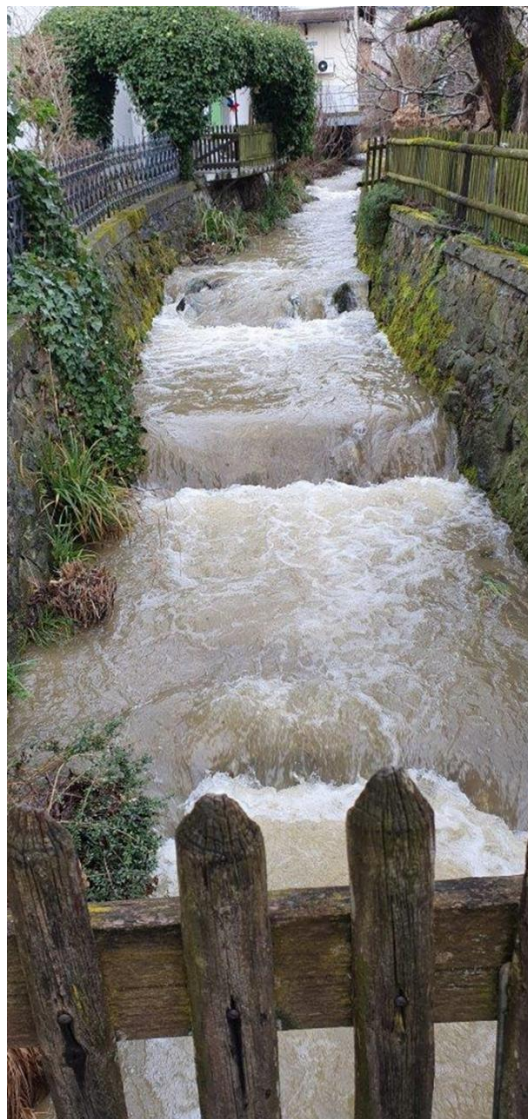
Dorfbach bachaufwärts Brücke bei Zwillikerstrasse 7 (© Gemeinde Hedingen, 2025)
