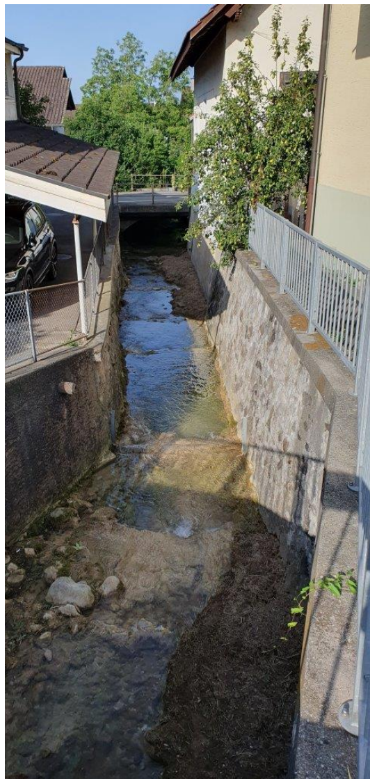
Dorfbach bachabwärts Richtung Vordere Zwillikerstrasse (© Gemeinde Hedingen, 2025)
