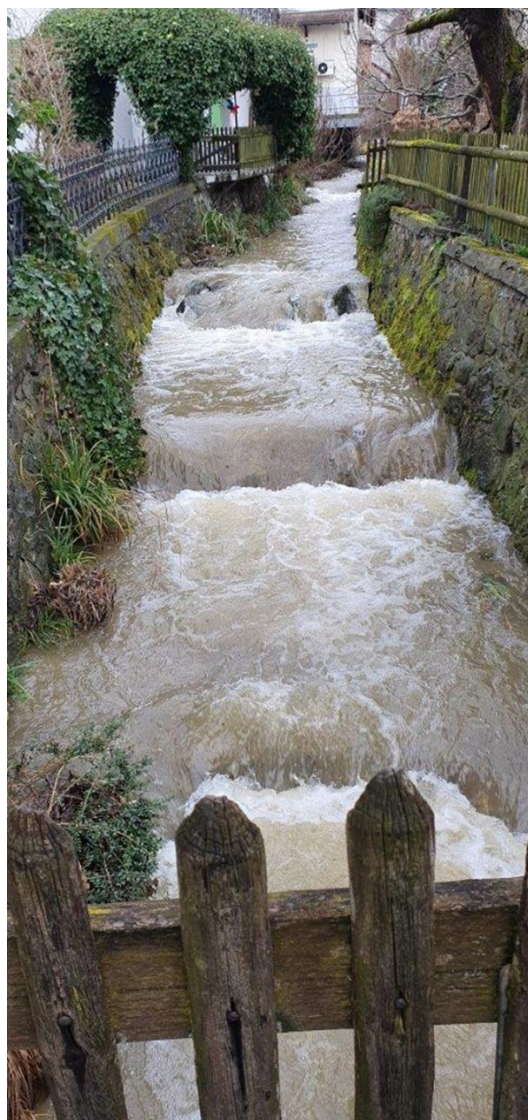
Dorfbach bachaufwärts Brücke bei Zwillikerstrasse 7 (© Gemeinde Hedingen, 2025)
