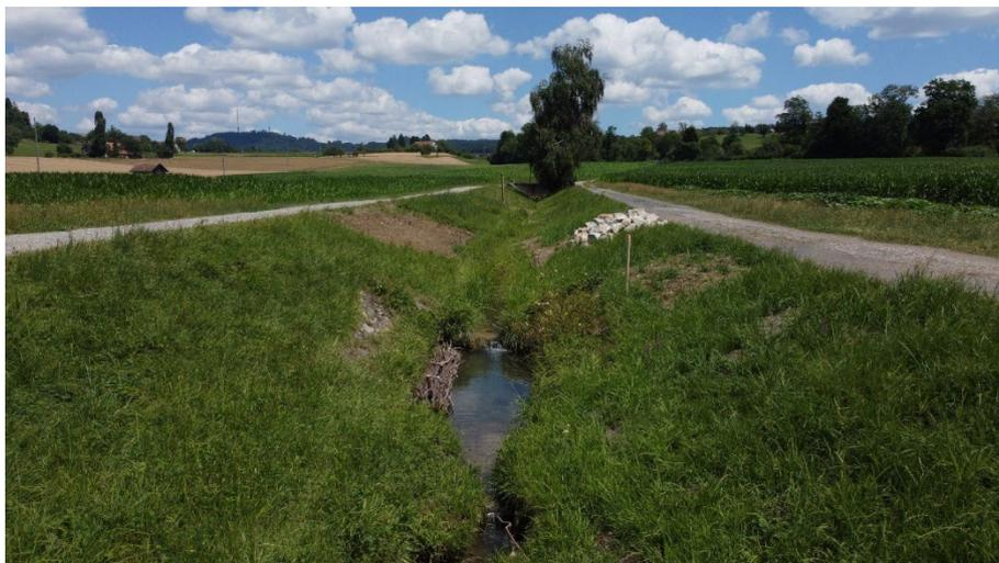
*Abbildung 5: Zwei Geschiebesammler im Perimeter wurden wie das Auslaufbauwerk "möbliert". Zur Verbesserung der Fischgängigkeit wurden zudem der Einlauf in das Bauwerk abgespitzt und im Unterlauf mit einer kleinen Schwelle zum ergänzt, die zu einem leichten Einstau des Beckens führt und so die Absturzhöhe ca. halbiert.*
